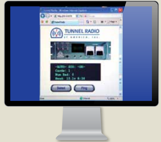
Monitor da rede remota do Sistema de Monitoramento do Túnel
